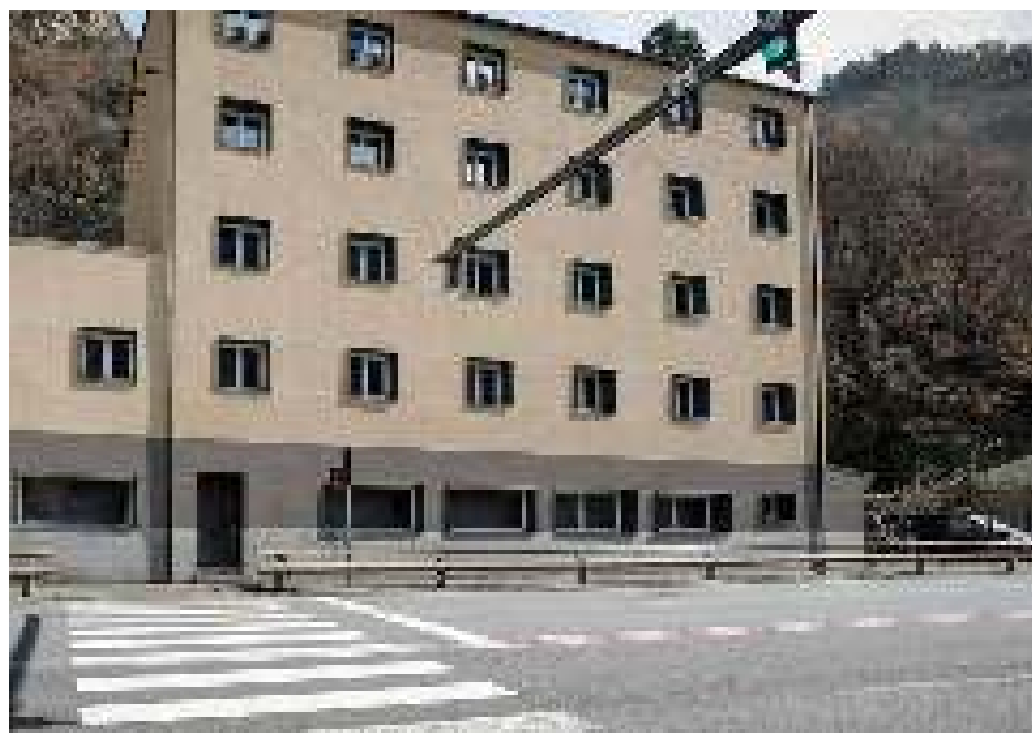
L'edifici Font de Ferro, situat a Sant Julià de Lòria.
