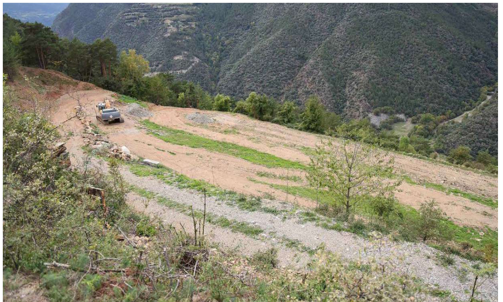
Estat actual de les obres del Dino Forest.
