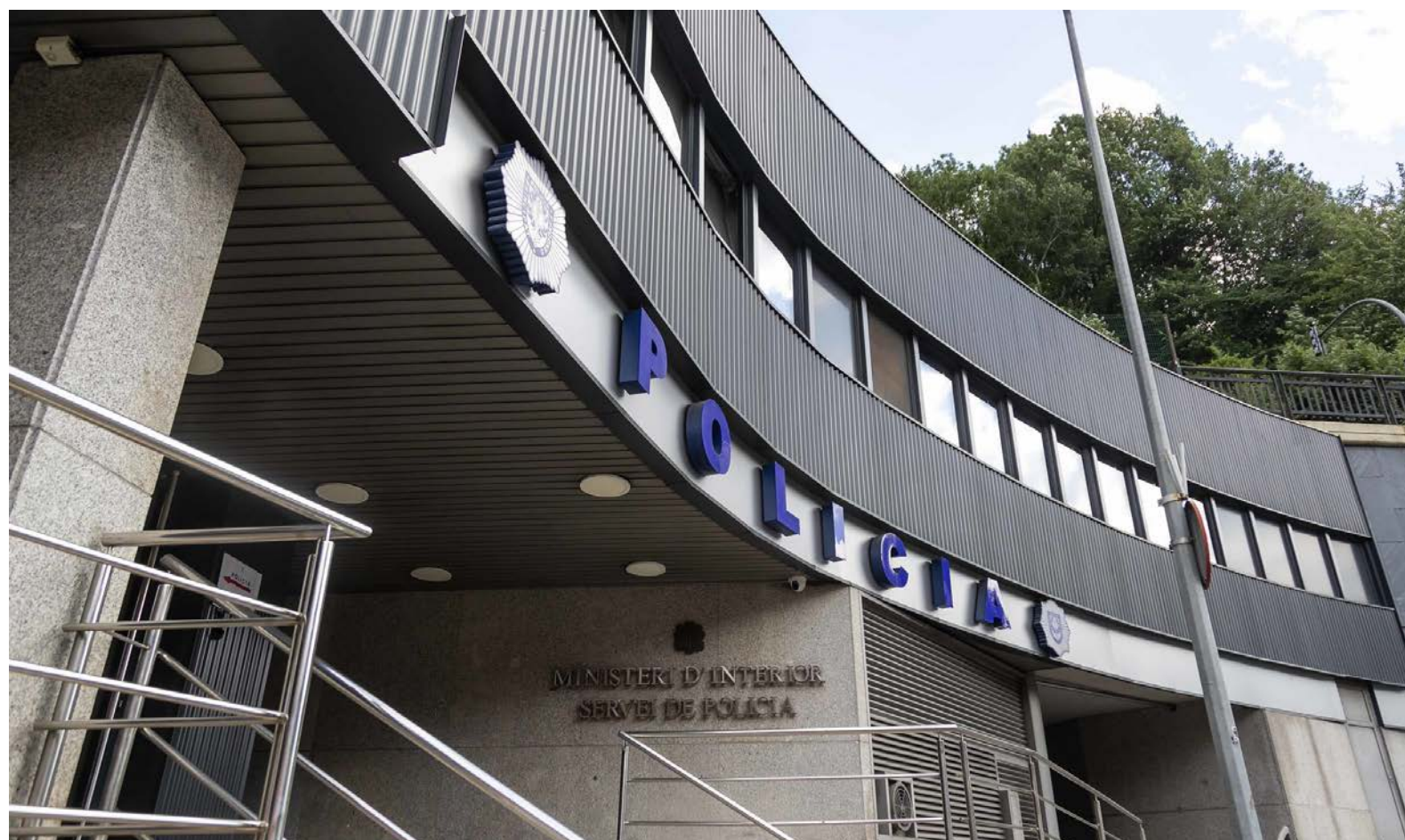
L'edifici administratiu de la Policia.
