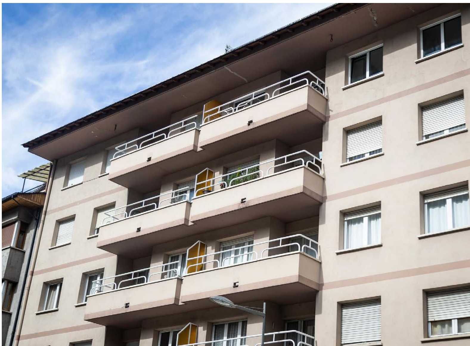
Diferents pisos situats a l'avinguda de François Mitterrand d'Encamp.
