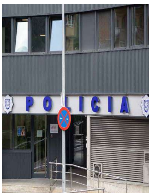
L'edifici administratiu de la Policia.
