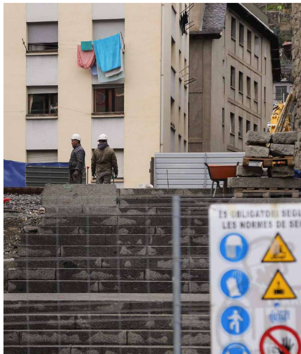
Les obres de l'entorn de Casa de la Vall.
