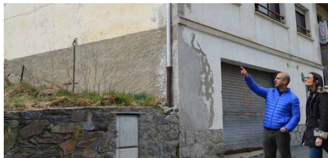
La parcel·la de la Casa Parramon, on s'ubicarà la futura Escola d'Oficis.
