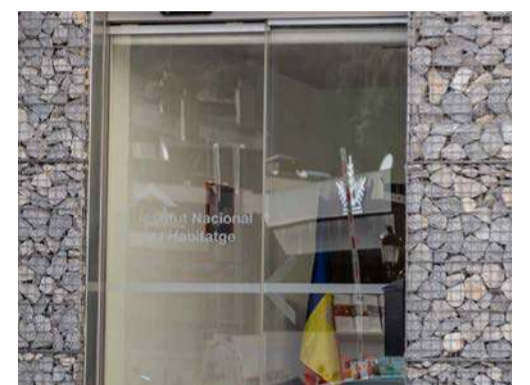
La façana de l'Institut Nacional de l'Habitatge.
