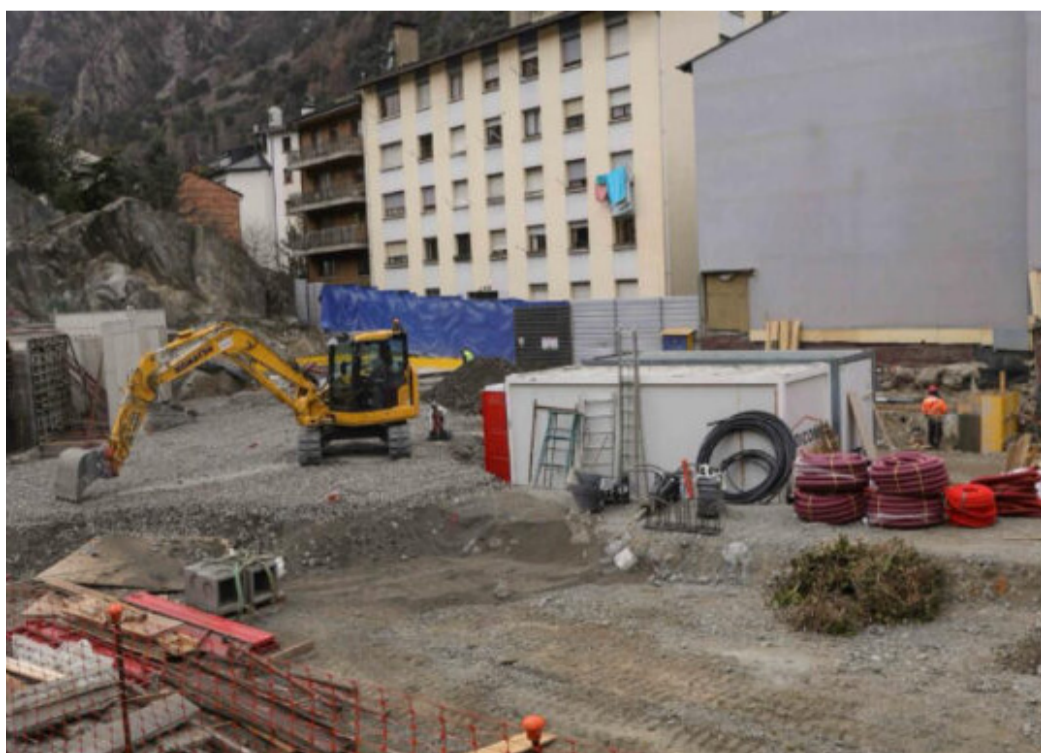
Les obres dels entorns de Casa de la Vall, ara fa unes setmanes.
