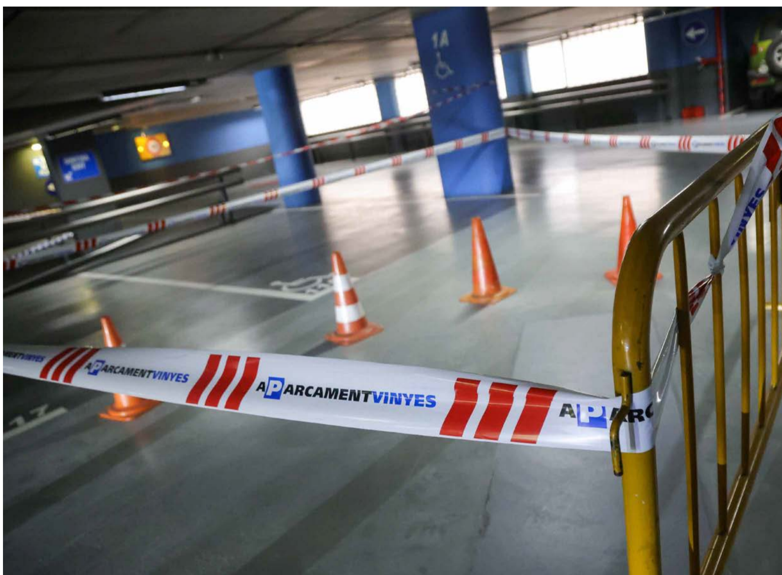
La zona afectada a l'interior de l'aparcament Vinyes.
