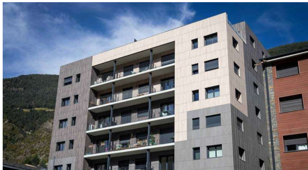
Un edifici del Principat.
