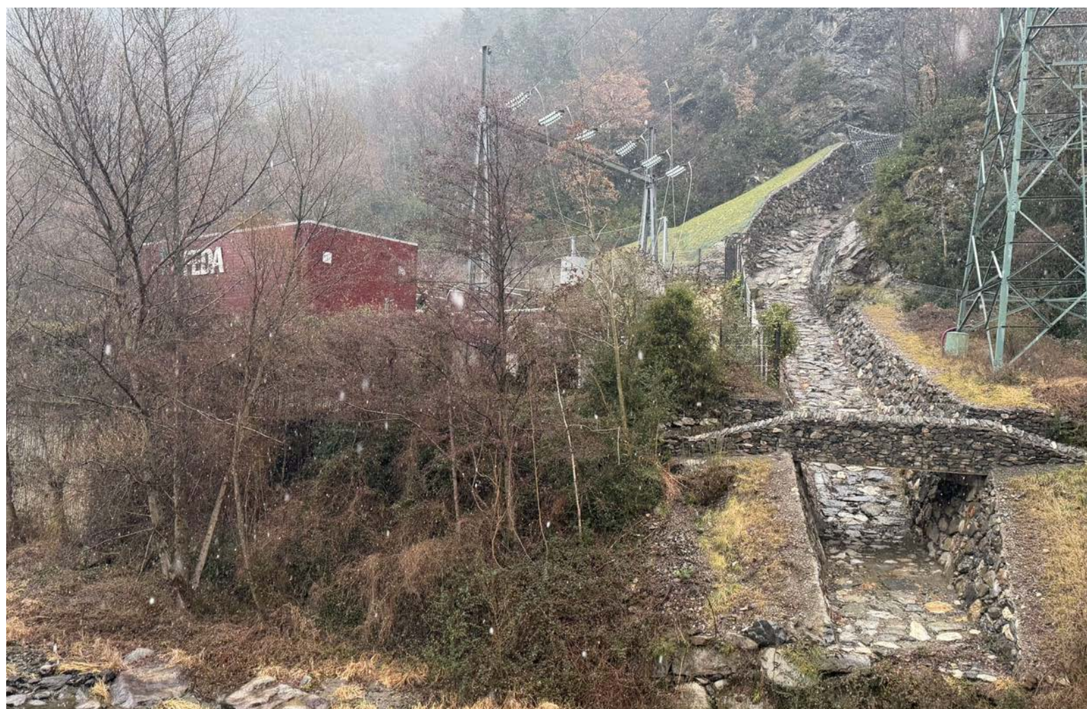
Els treballs han incorporat un segon projecte centrat en la protecció de la instal·lació davant riscos geològics.
