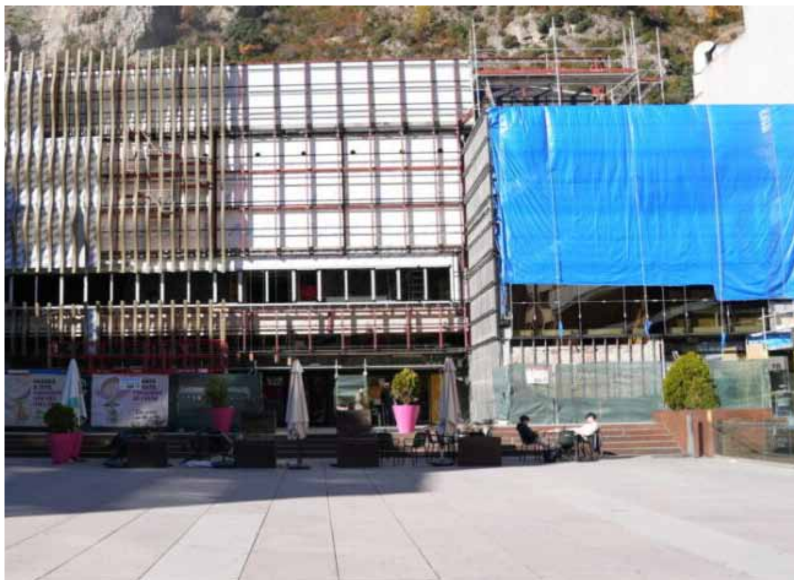
La façana del Centre Cultural lauredià en obres.
