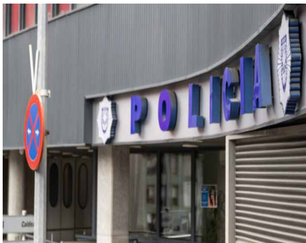
La façana de l'edifici administratiu de la Policia.
