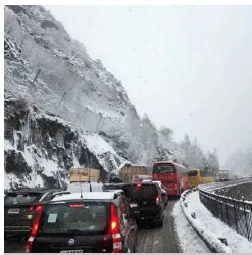
Col·lapse d'ahir a la zona de la Trava.
