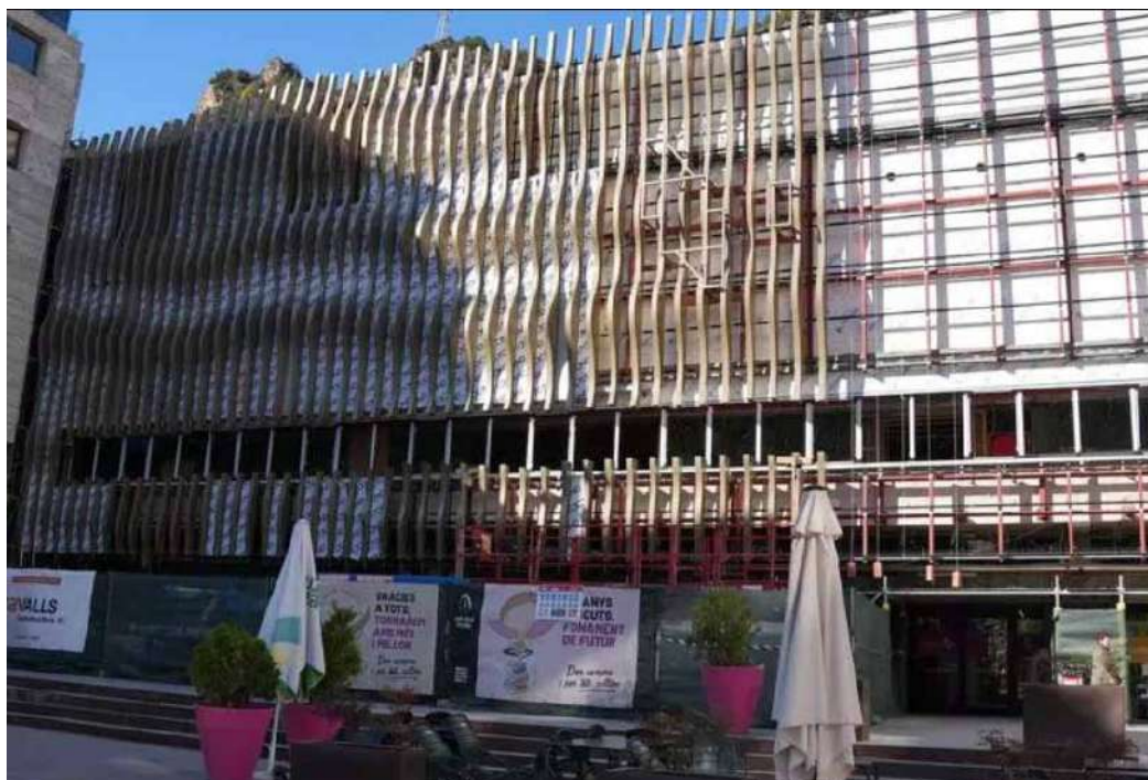
La façana del Centre Cultural lauredià.
