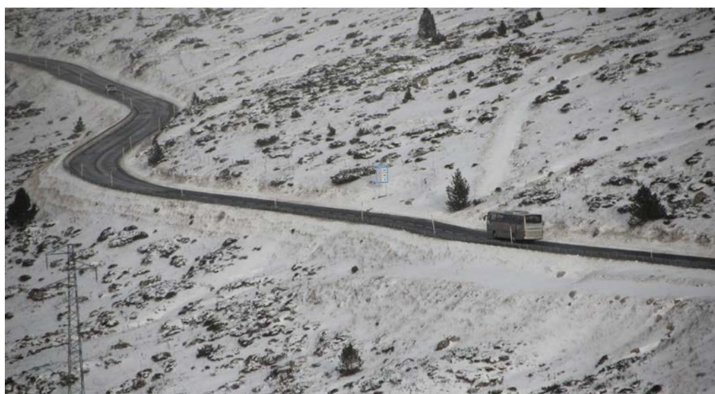
Tancament preventiu de la carretera d'accés a França.
