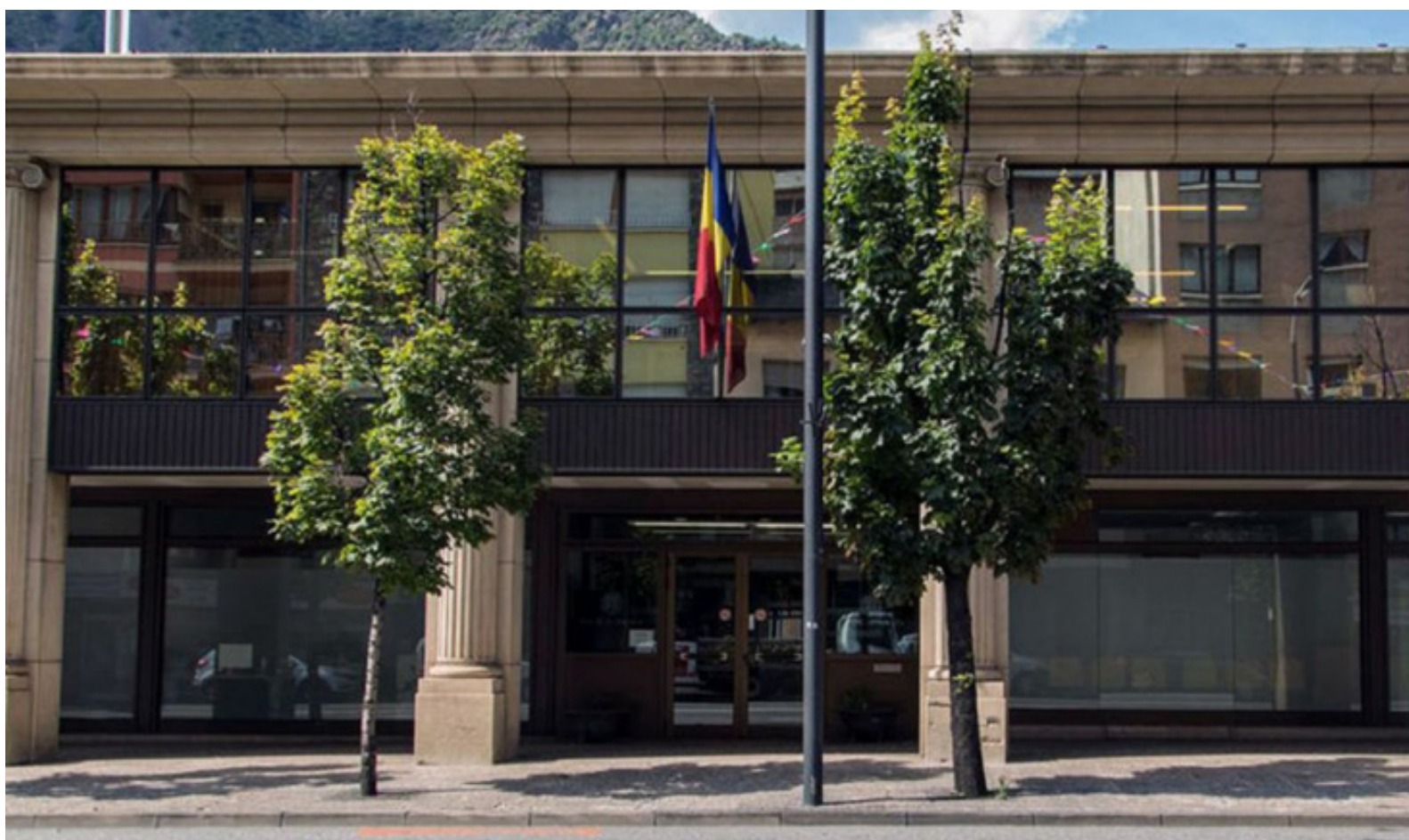
L'edifici de les Columnes d'Andorra la Vella.
