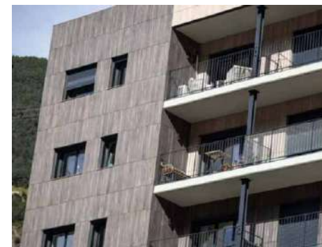
Un edifici del Principat.
