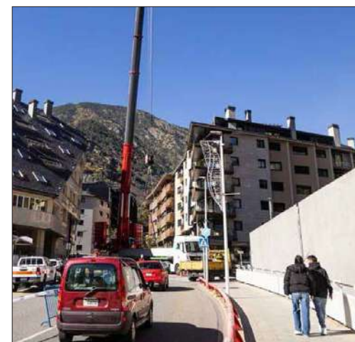
La grua necessària per fer la instal·lació.
