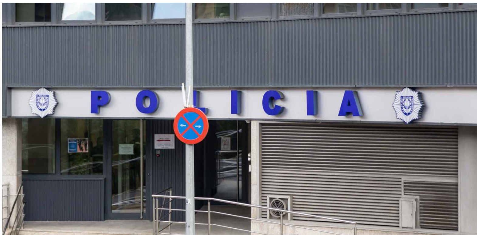
La façana del Despatx Central de Policia.
