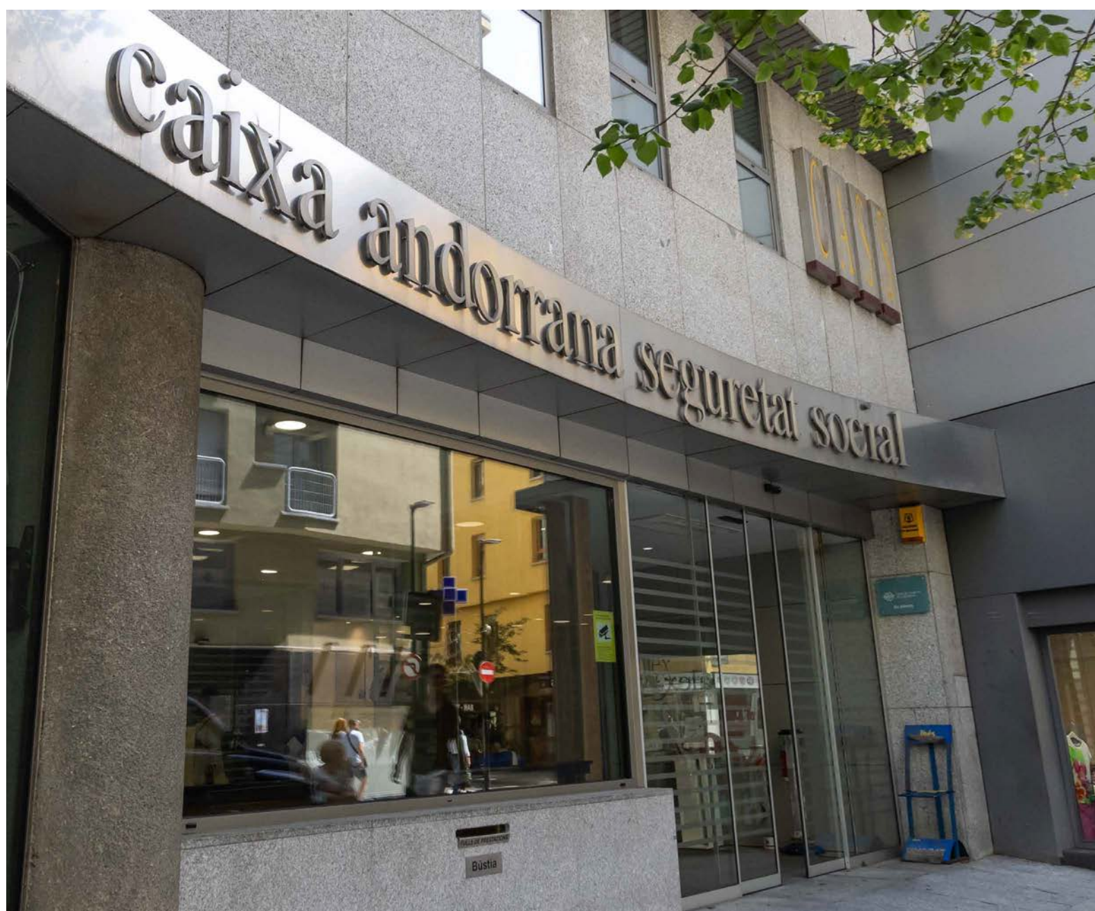
L'edifici de la Caixa Andorrana de Seguretat Social (CASS).
