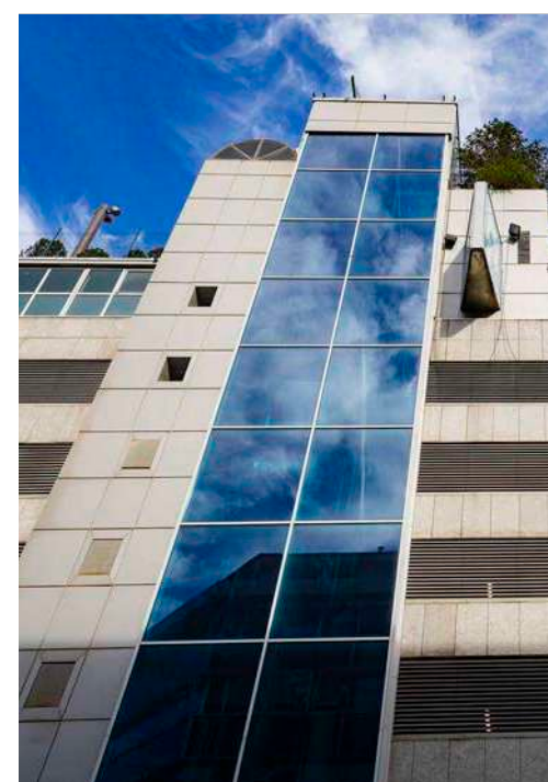
Els ascensors panoràmics seran substituïts.
