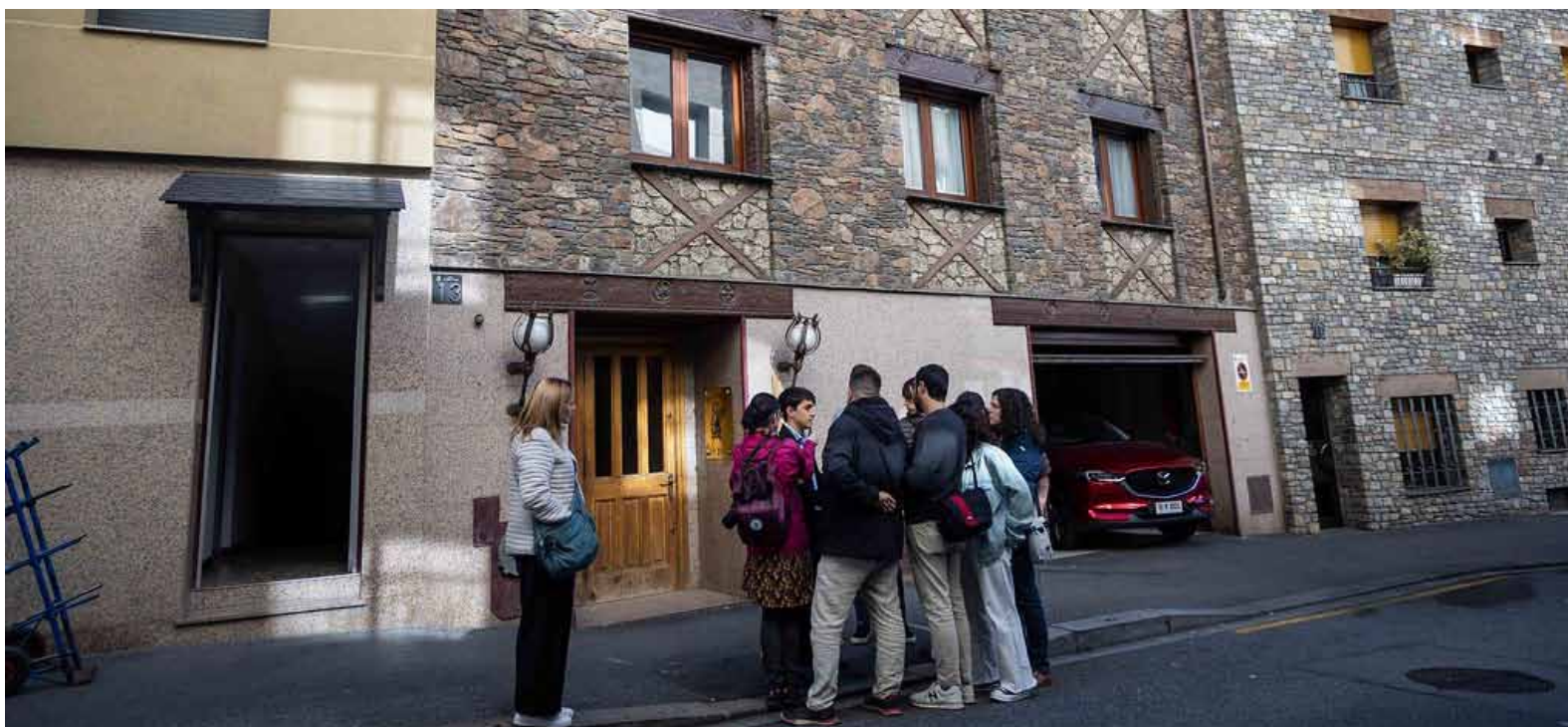
L'edifici se situa al número 13 del carrer Roureda de Sansa, amb accés principal per l'avinguda Santa Coloma, 24.
