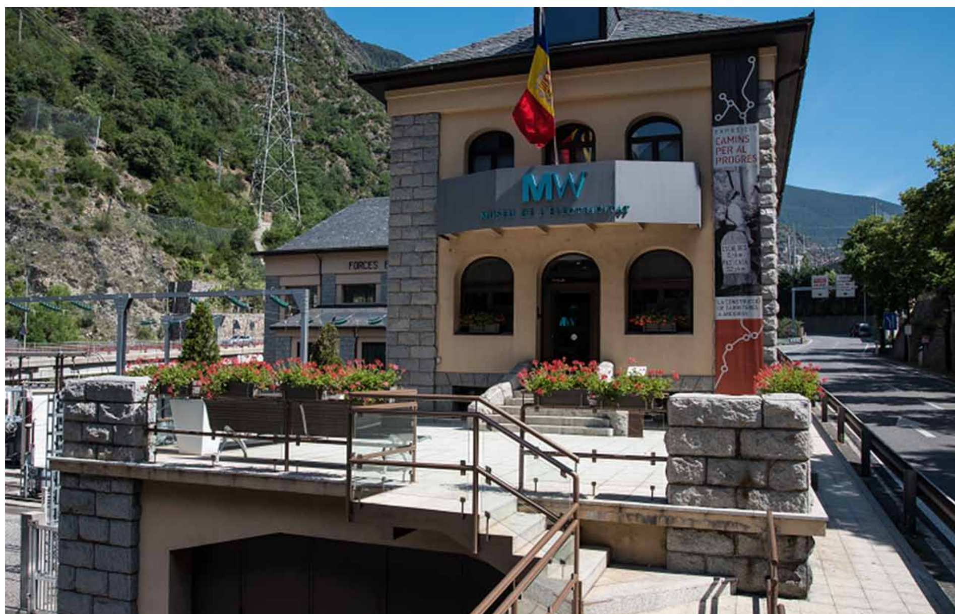
La seu del Museu Hidroelèctric.
