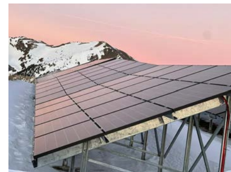
Andorra Telecom genera 20 tones.
