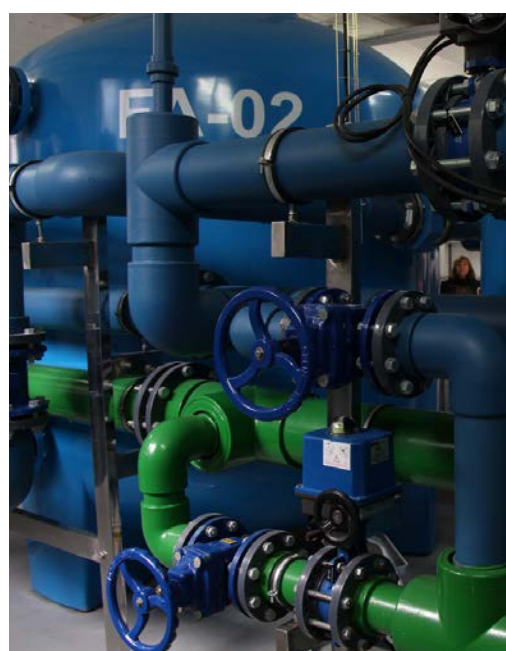
Una imatge d'arxiu del dipòsit de la Birena.
