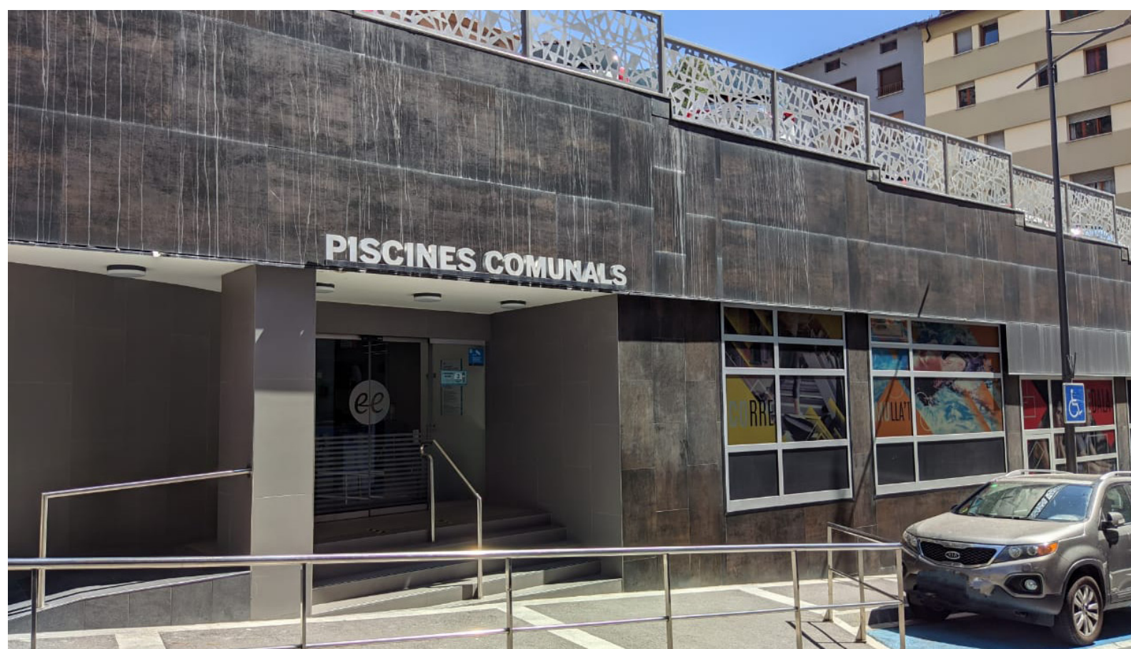
Les piscines comunals d'Escaldes-Engordany.
