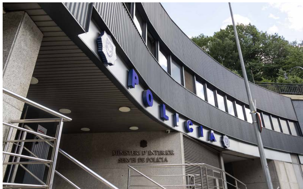
La façana de l'edifici administratiu de la Policia.
