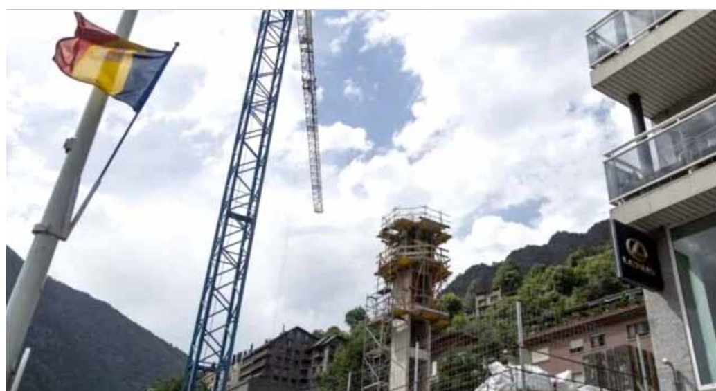
Estat actual de l'edifici d'habitatge de lloguer assequible en construcció a l'avinguda del Pessebre, a Escaldes-Engordany.
