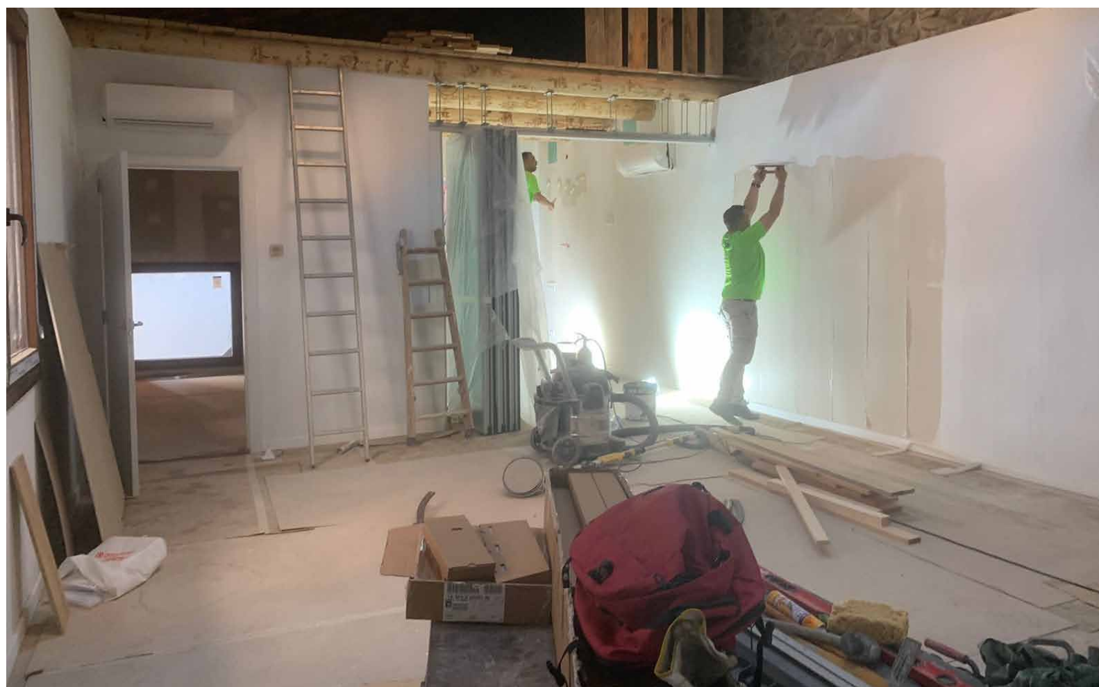
La darrera fase de les obres de borda Gabriel.
