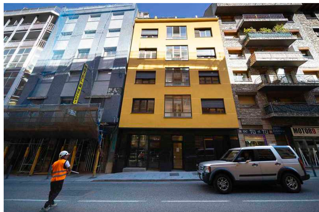
Els habitatges de l'avinguda Santa Coloma afectats per les esquerdes.
