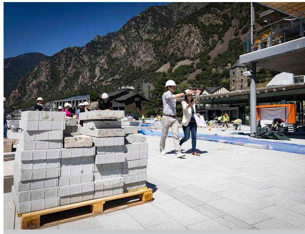
La cònsol Olalla Losada i el conseller Jordi Cabanes, durant la visita a les obres.
