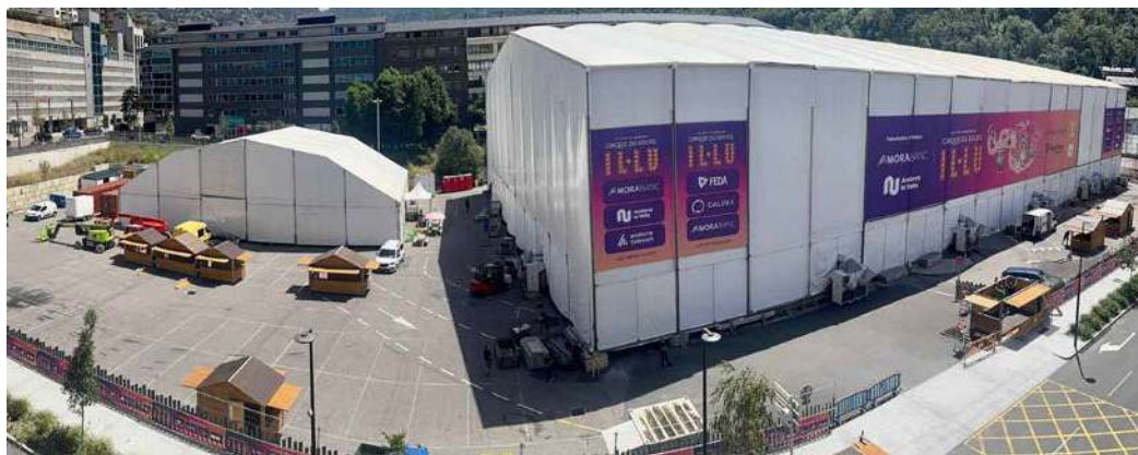
Vista aèria de l'envelat on actuarà el Cirque du Soleil.
