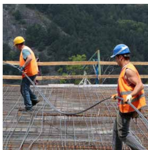
Uns treballadors a l'obra.
