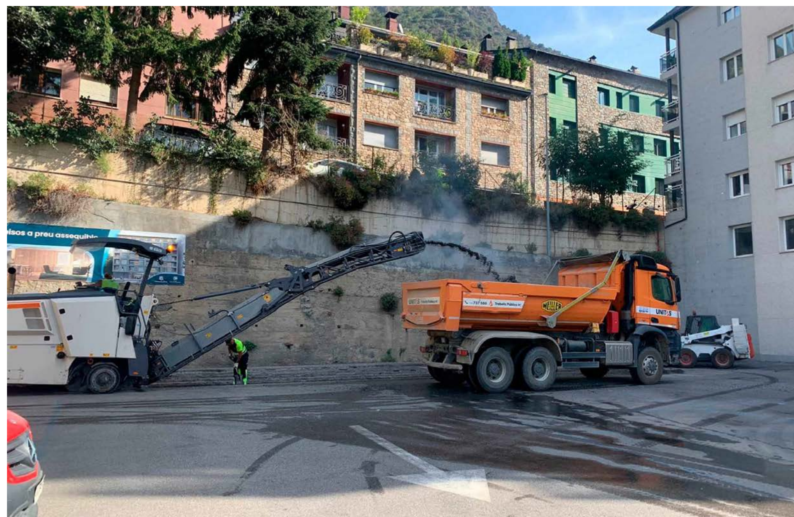
Operaris intervenint en una construcció d'Escaldes-Engordany amb l'ajuda de diferents vehicles pesants.
