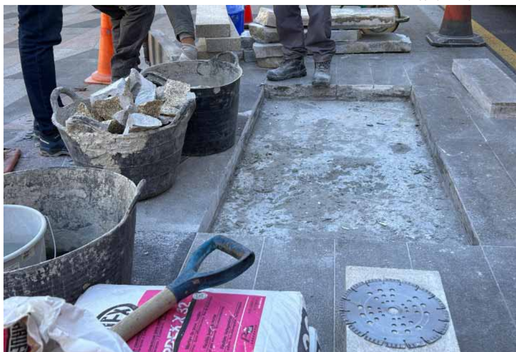
Reparació d'una voravia al centre d'Andorra la Vella.
