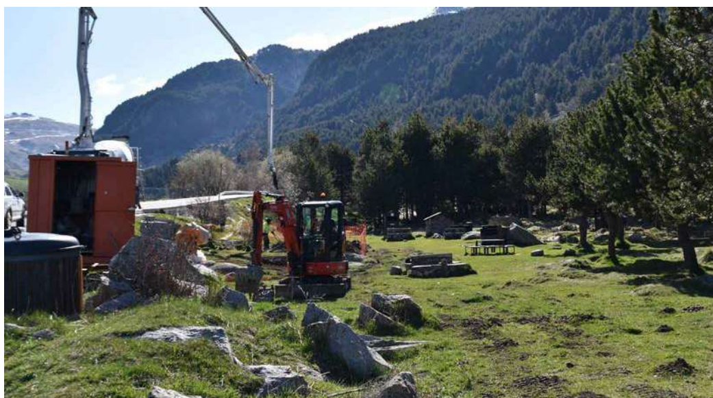
Els treballs que s'estan duent a terme a la zona del berenador dels Cortals d'Encamp.
