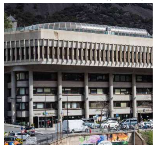
L'edifici administratiu del Govern.
