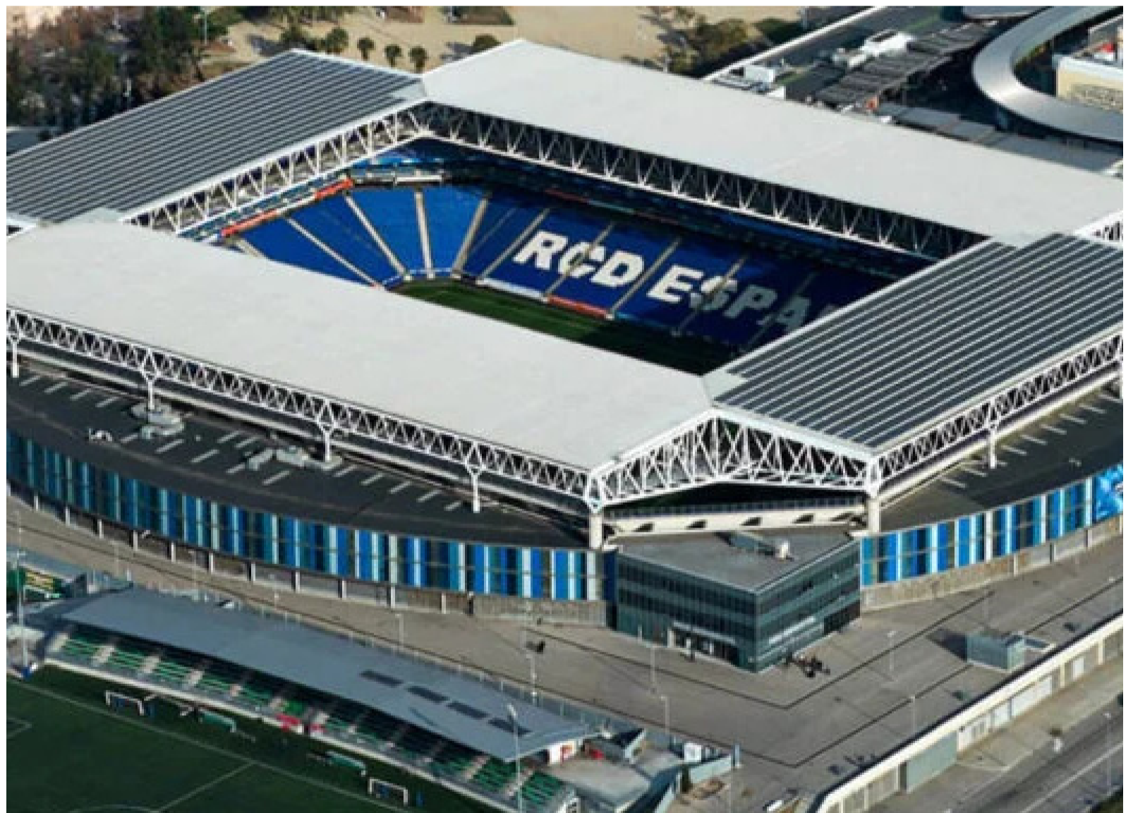
Vista aèria de l'RCDE Stadium, a Cornellà-El Prat.
