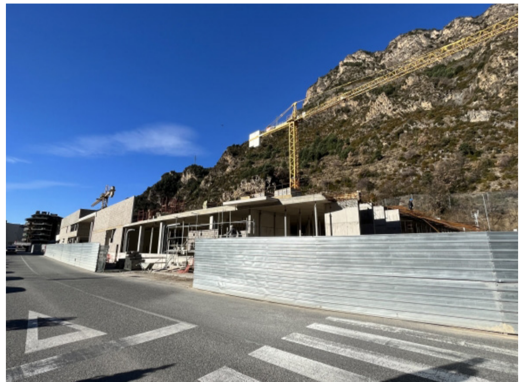
Unes obres en construcció en un edifici de Sant Julià de Lòria.
