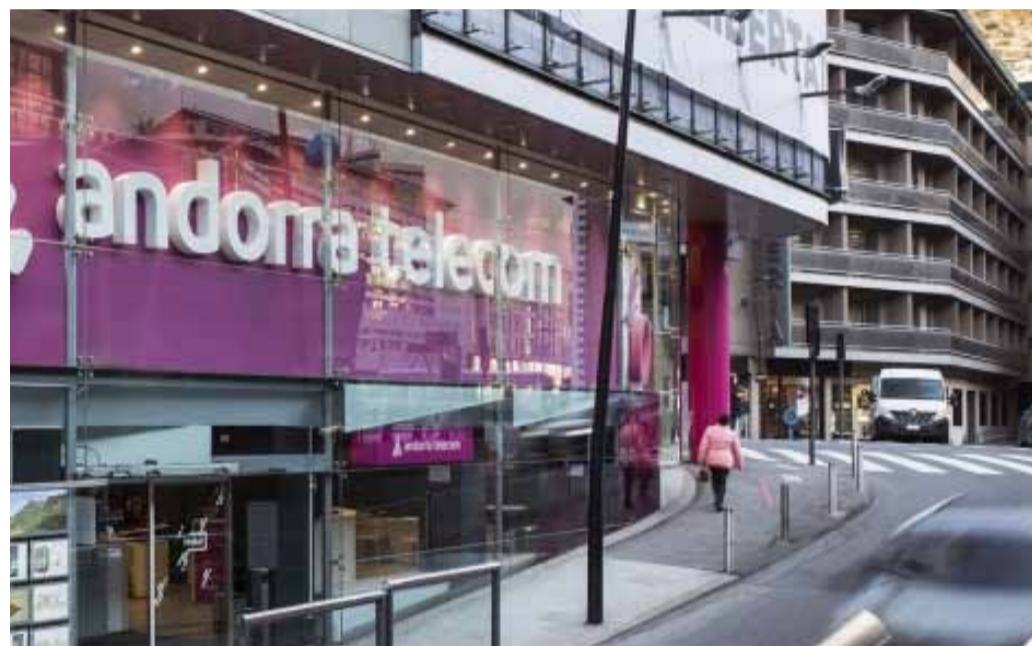
La façana d'Andorra Telecom situada a l'edifici Andimesa d'Andorra la Vella.
