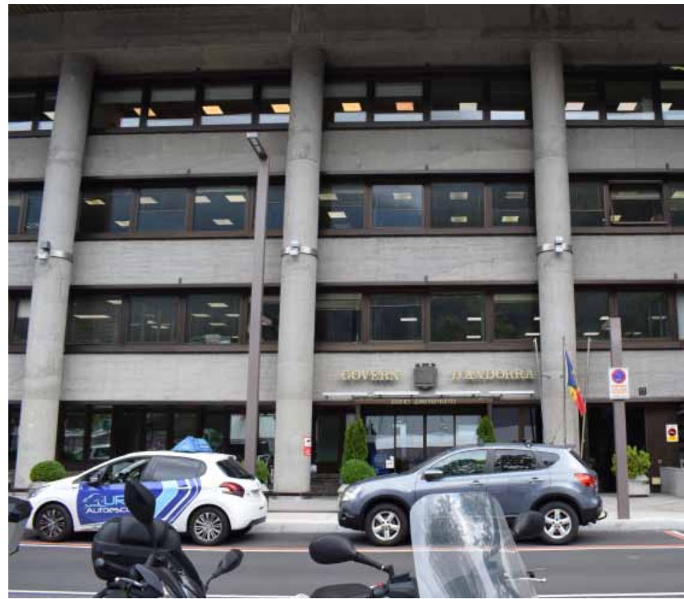
L'edifici administratiu del Govern.
