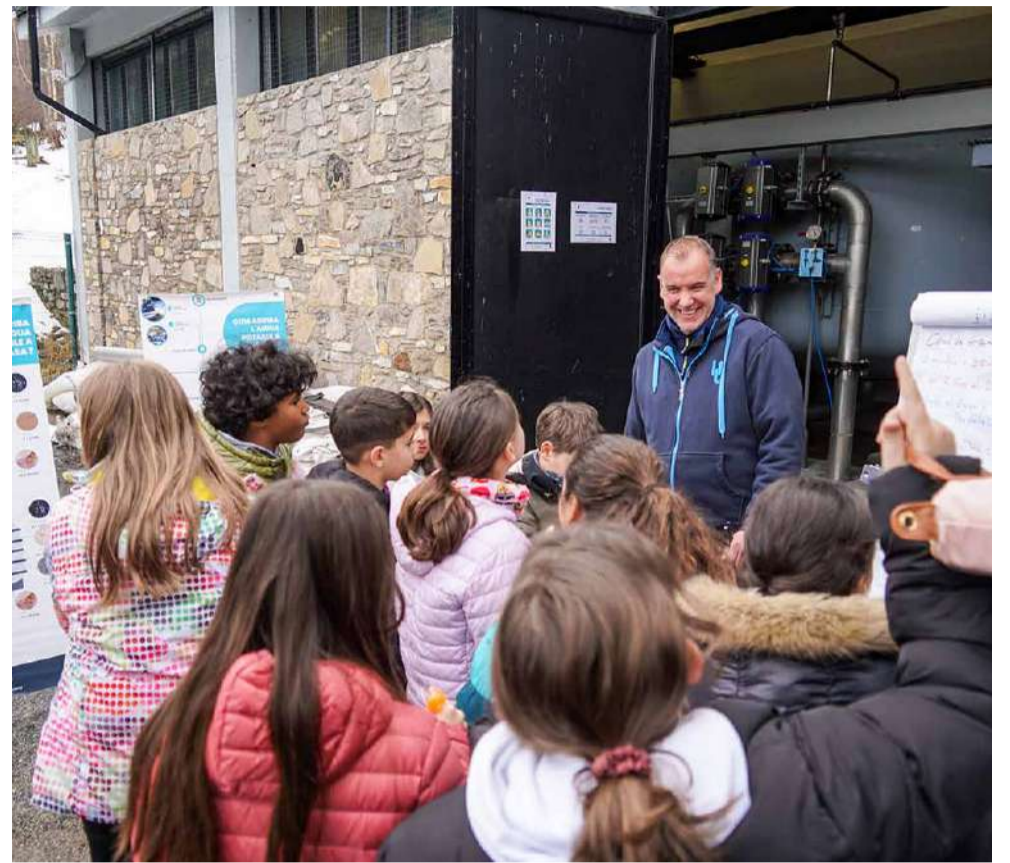
Visita escolar a l'ETAP de les Pardines.
