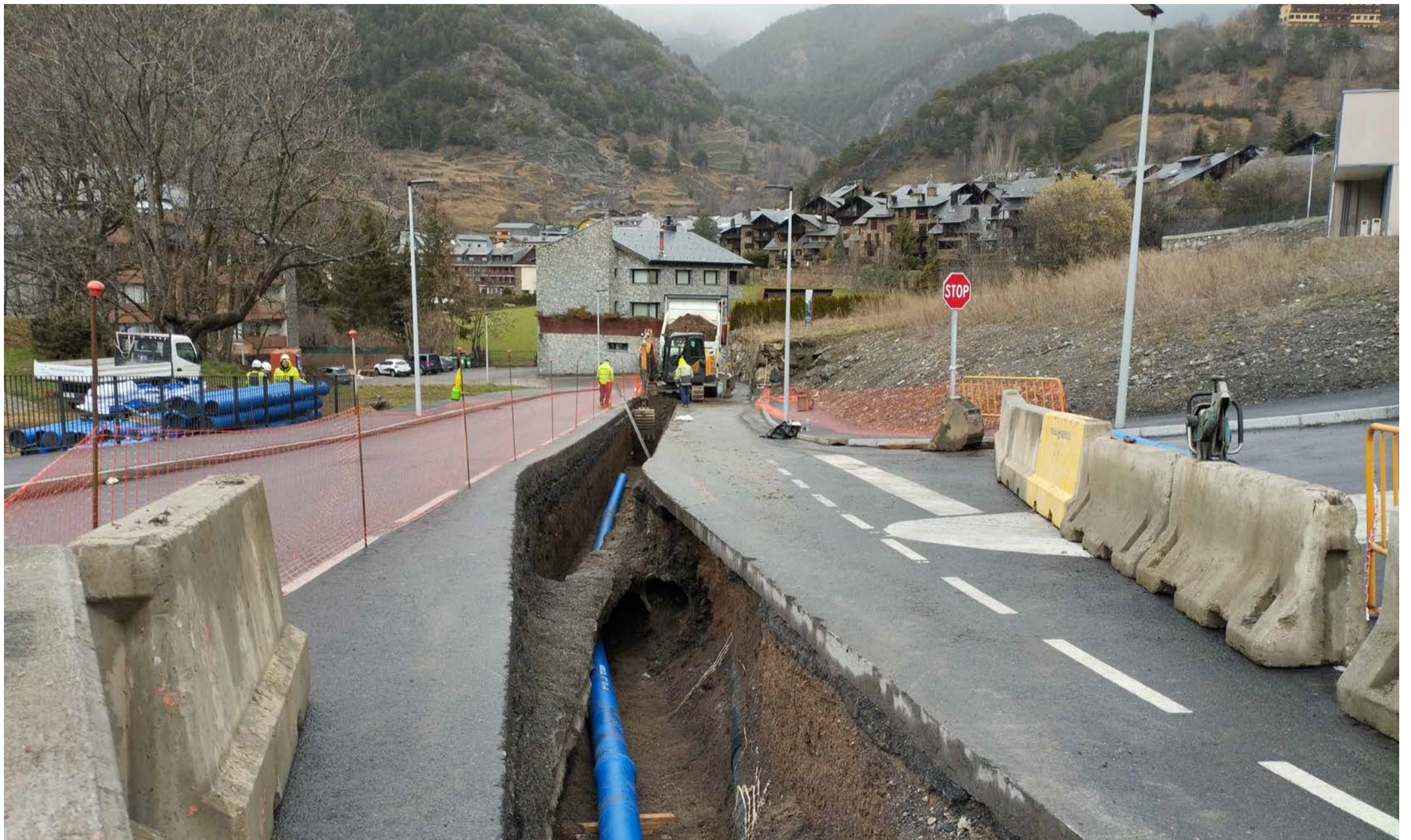
Les obres que s'estan duent a terme, aquest matí.
