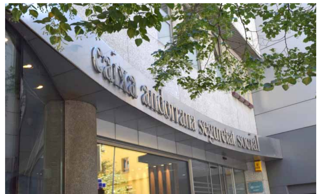
La façana de les dependències de la Caixa Andorrana de Seguretat Social.
