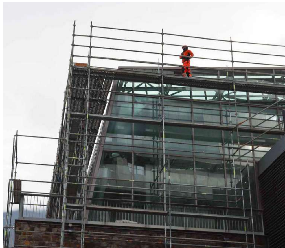
Les obres que s'estan duent a terme a l'exterior del pavelló.
