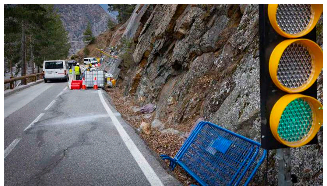
Les obres a la carretera de la Comella.
