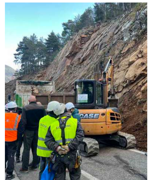
Els treballs a la carretera de la Comella.
