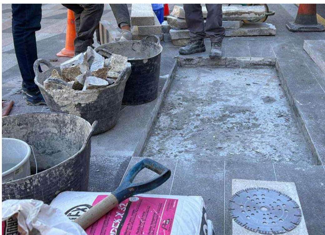
L'actuació forma part del pla integral que s'està duent a terme als punts més crítics.
