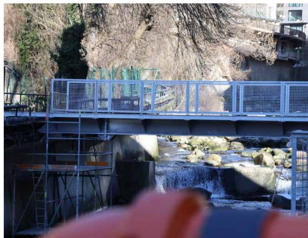
La passarel·la ja col·locada després dels treballs fets per la grua ubicada a la zona.
