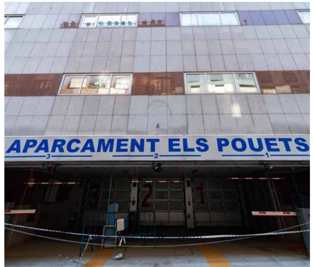
Imatge actual de l'aparcament dels Pouets, a Andorra la Vella.
