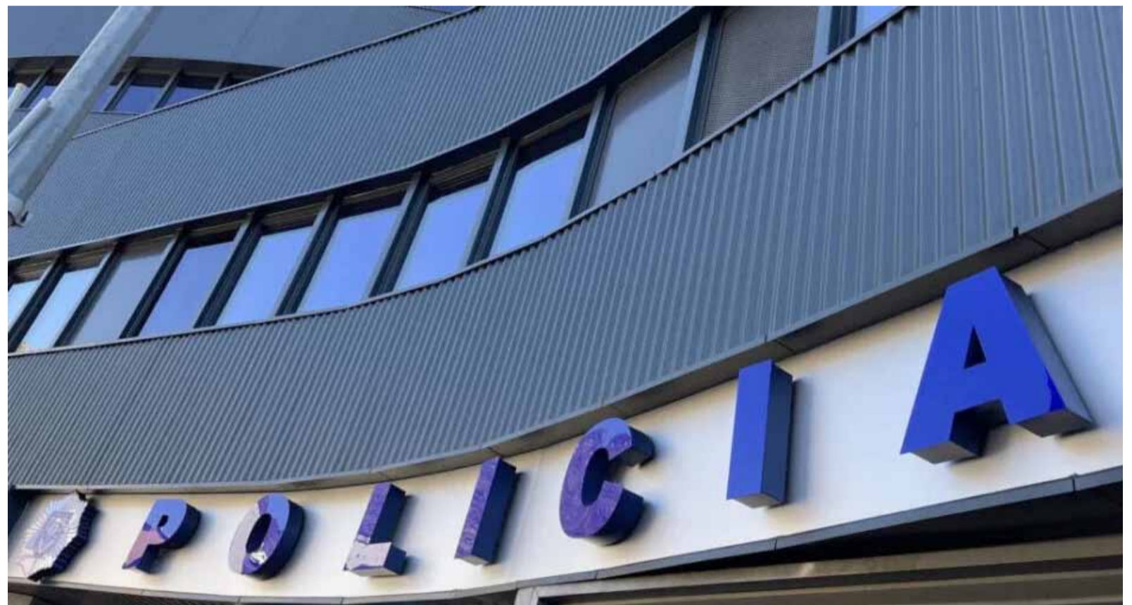
Les dependències de l'edifici de la Policia, a Escaldes-Engordany.
