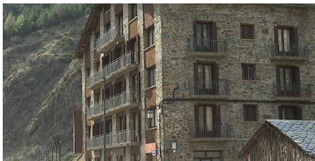
L'edifici d'habitatges a preu assequible situat a l'avinguda Sant Joan de Caselles.
