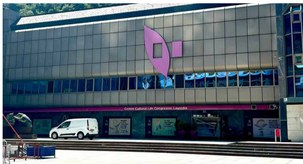
Imatge del Centre Cultural de Sant Julià de Lòria el passat estiu.
