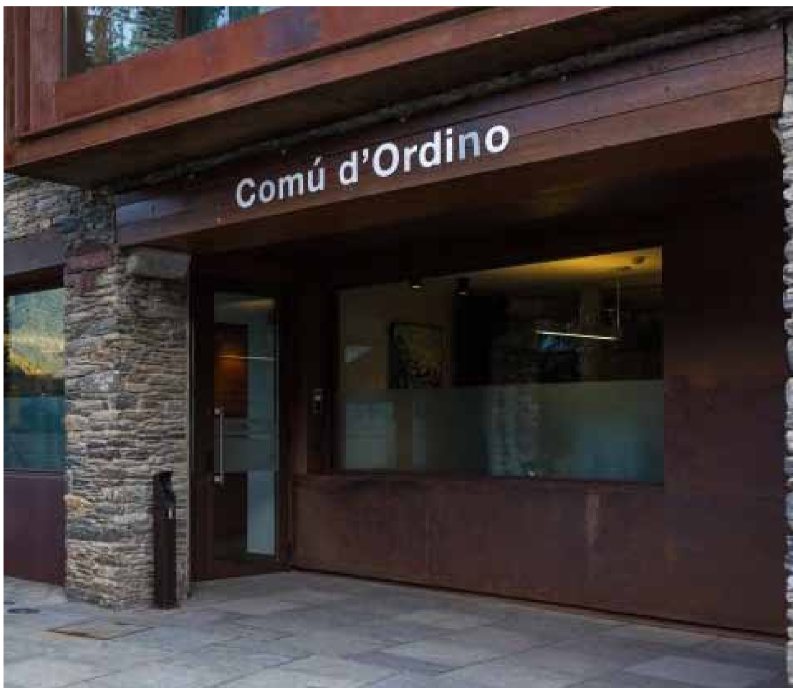
La façana del Comú d'Ordino.
