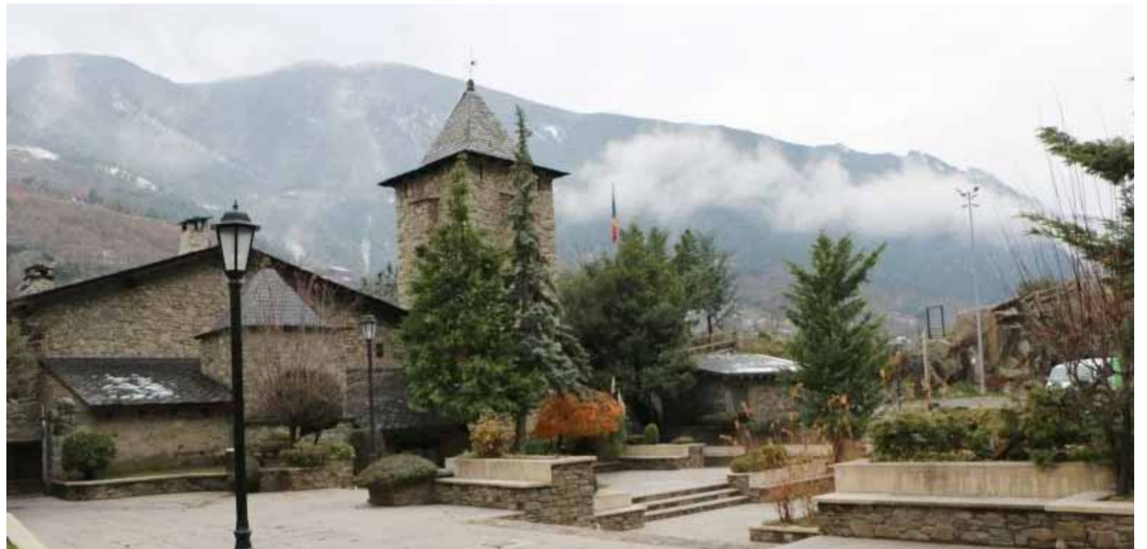
La zona posterior i de jardins de la Casa de la Vall on es durà a terme la primera fase de remodelació.
